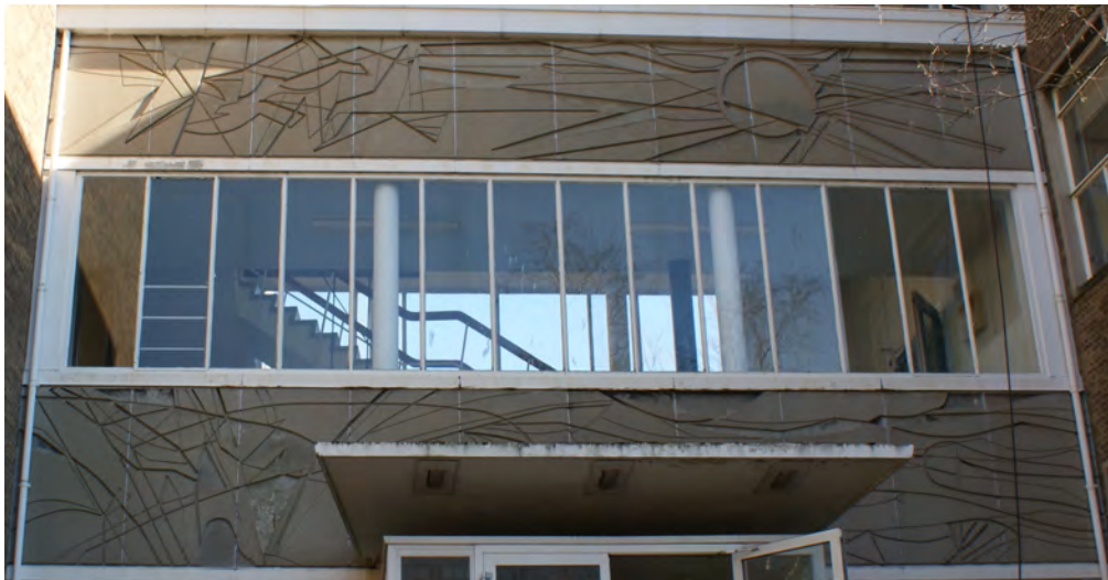
Betonreliëf voorgevel, Situatie maart 2015
